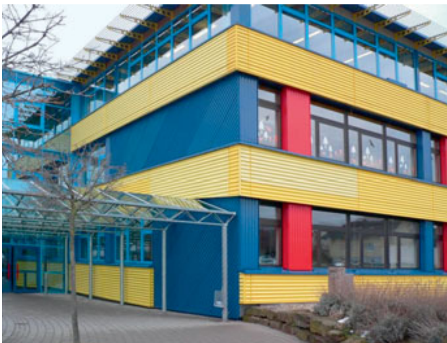
Bei dieser Fassade eines Industriegebäudes wurden Beschichtungsstoffe verschiedener Hersteller angewendet.
